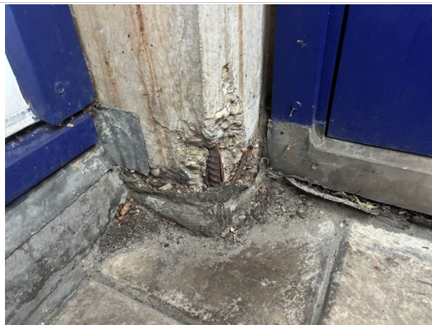
Foto 5.10: Detail grindnest kolom balkon
