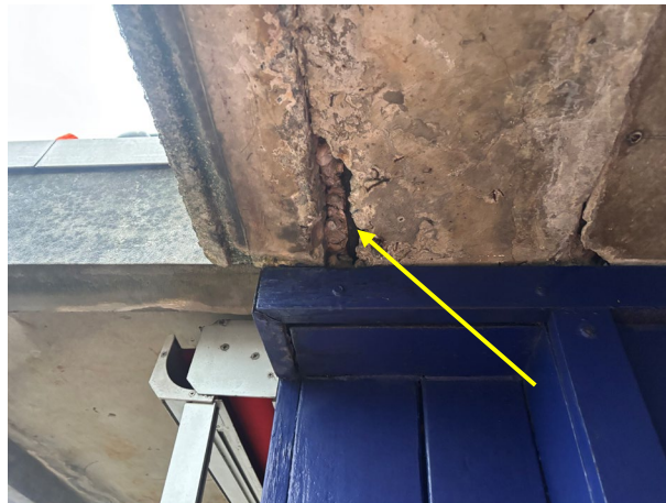
Foto 5.8: Overzicht grindnest dak balkon
