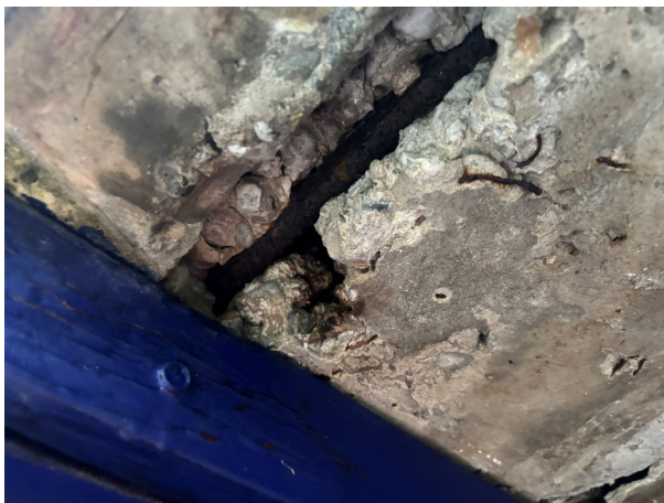
Foto 5.9: Detail grindnest dak balkon
