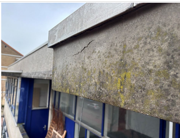
Foto 5.5: Scheur in de dikte kant van de luifel
