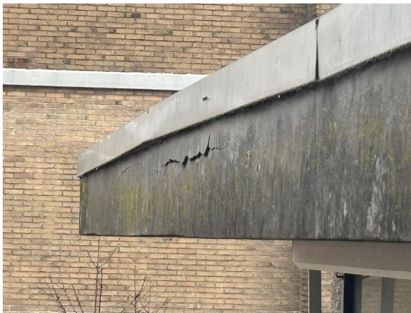
Foto 5.1: Horizontale scheur
